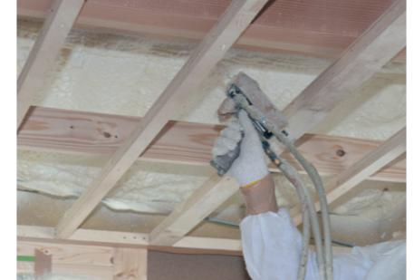
強力な自己接着力で、複雑な形状にも断熱材を隙間なく充填。隙間からの熱損失が大幅に減少します。
